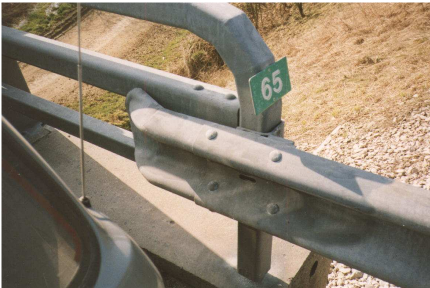
Postup prác: Očistenie vysokotlakou vodou Zinga 2 x 50 \mu m
