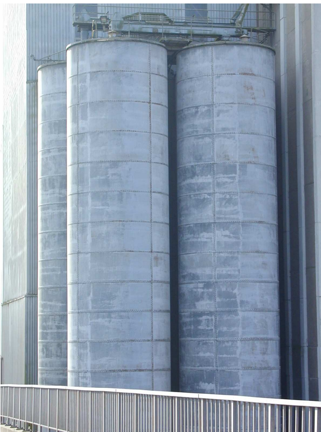
Renovácia žiarovo pozinkovaných síl Snímky zhotovené 20 rokov po aplikácii
